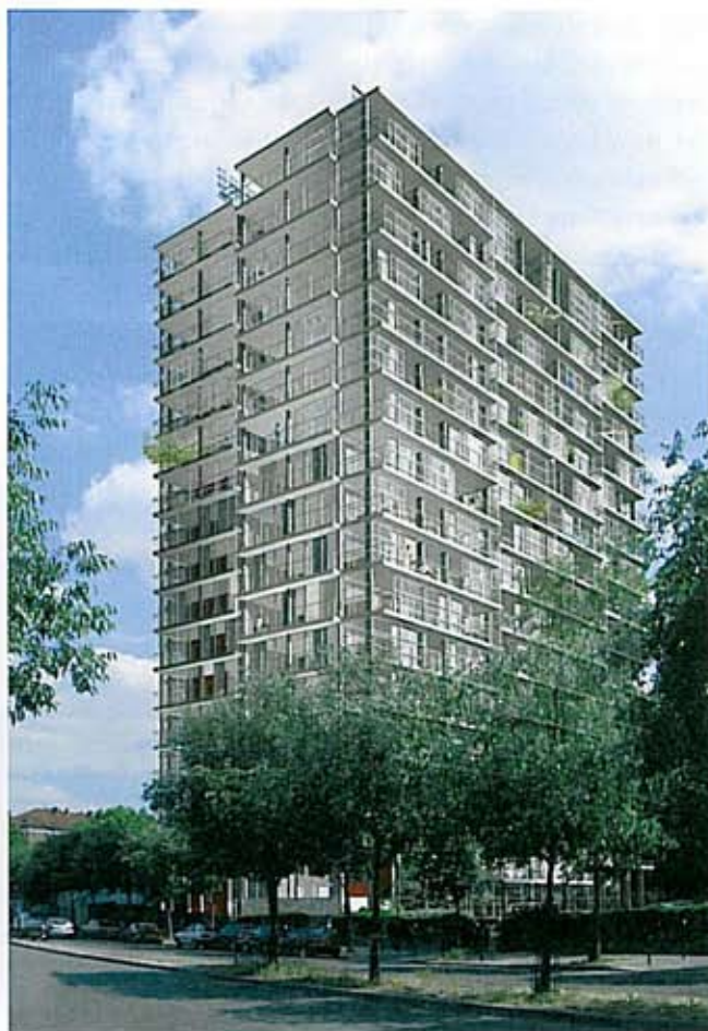
Der Tour Bois-le-Prêtre in Paris im Jahr 1961, nach der haustechnischen Sanierung 1990 und nach dem geplanten Umbau 2008.
